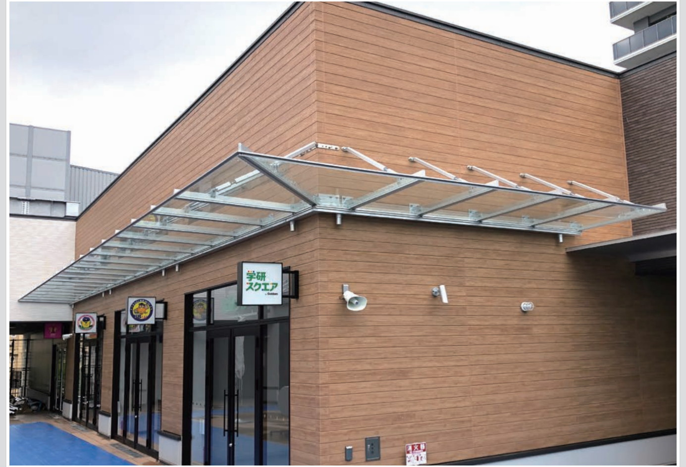
AGAT-100-3-2 強化合わせガラス庇(出隅コーナー仕様) W16515+5250×D1400mm(p34参照)
