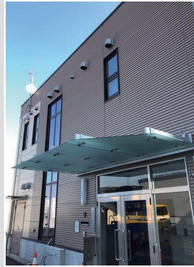
AGAT3-3000-1 強化合せガラス底(隅切り加工仕様) W4000×D2000mm(p36参照)
