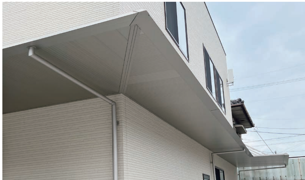
ALF3750-2AT(特注) 出隅コーナー出幅違い加工仕様・アルミ55φ縦樋付
